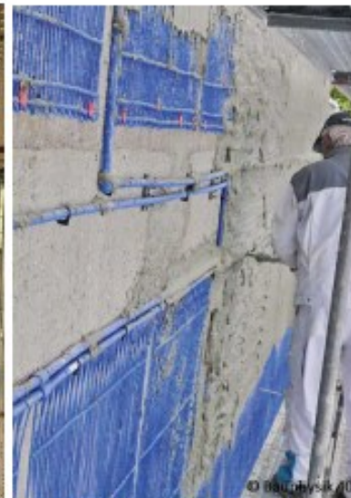
Abbildung 3: Überputzen der Heizrohrmatten
