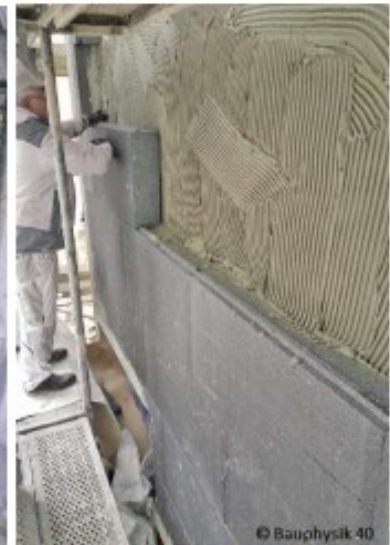
Abbildung 4: Wärmedämmung kleben
