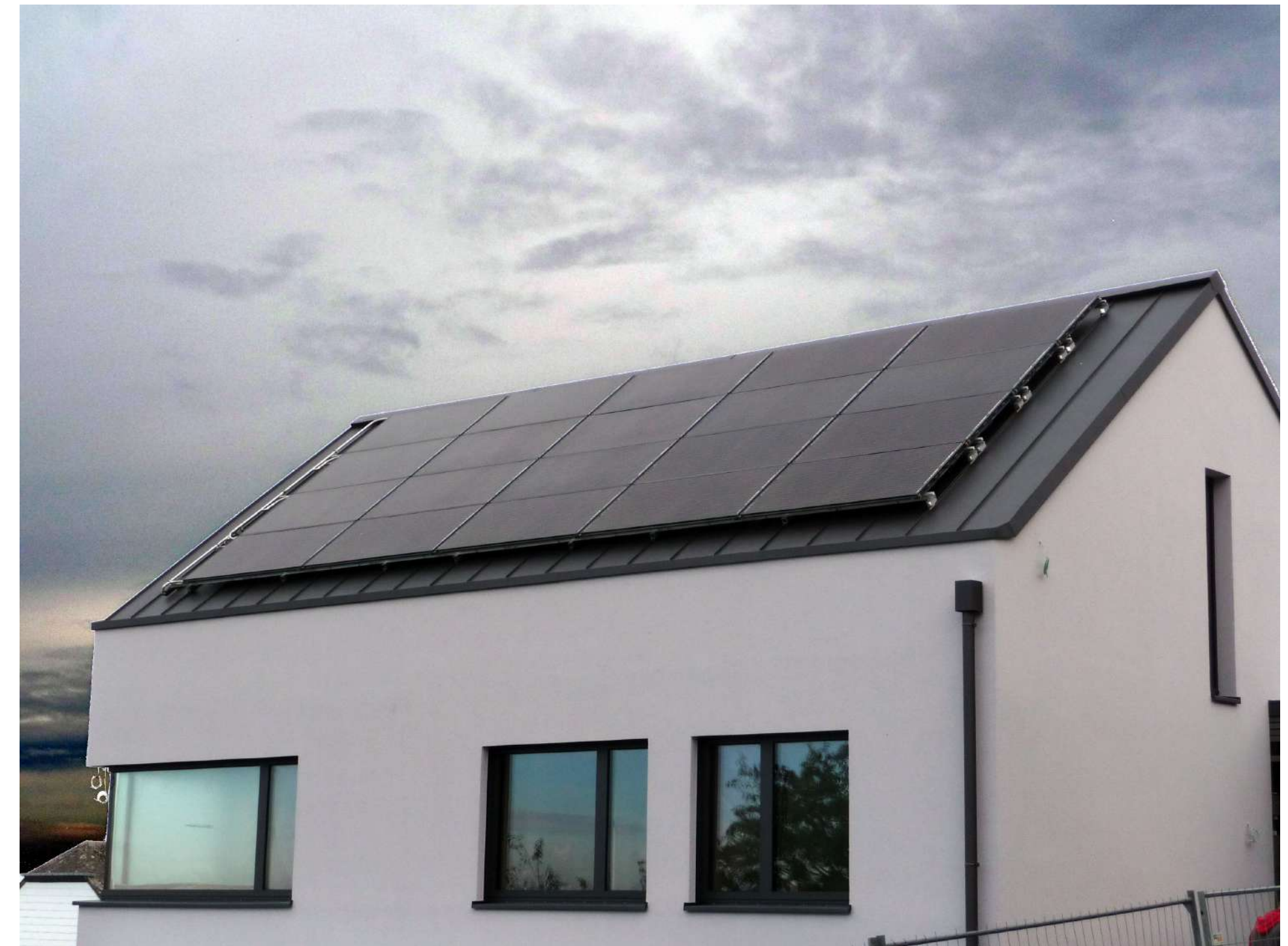
Luxemburg, 20 Kollektoren (Montage auf Blechfalzdach bauseits)
