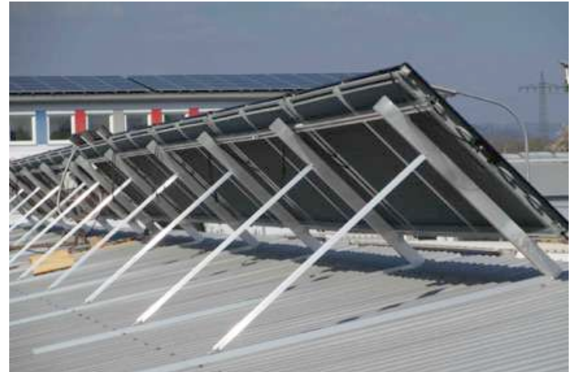
Consolar Gebäude, Lörrach (Vorserie-Montagegestell)
